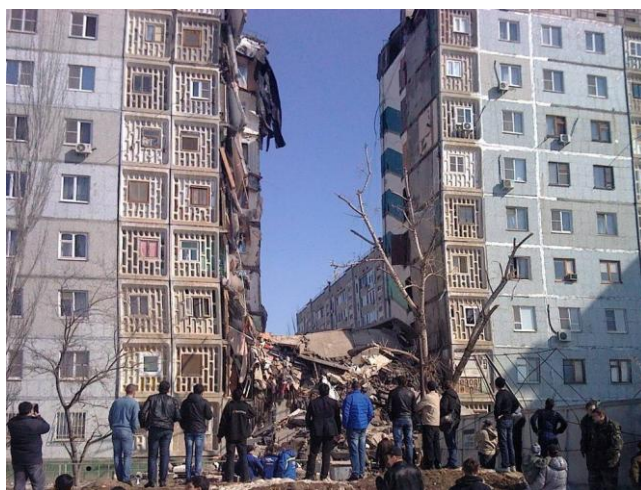
Момент лавинообразного обрушения секции 9-этажного крупнопанельного жилого дома в г. Астрахани
