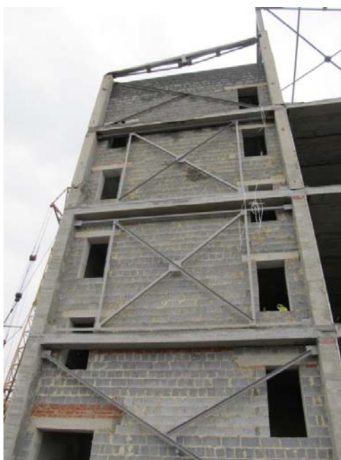
Рис. 1. Конструкция вертикальных связей по колоннам торгово-развлекательного комплекса
