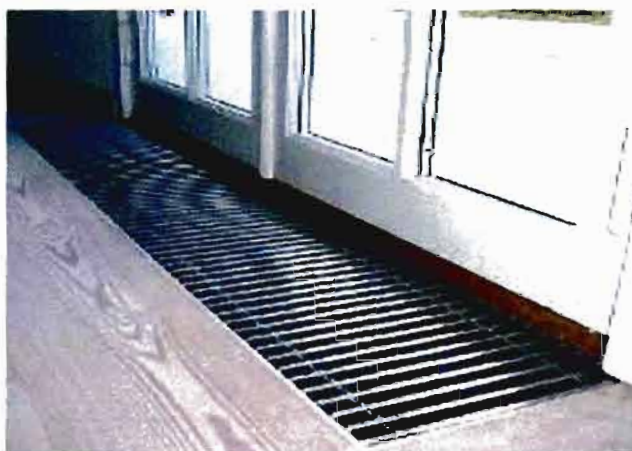
Рис. 1 Конвектор MOHLENHOFF GSK 320-110-2000
