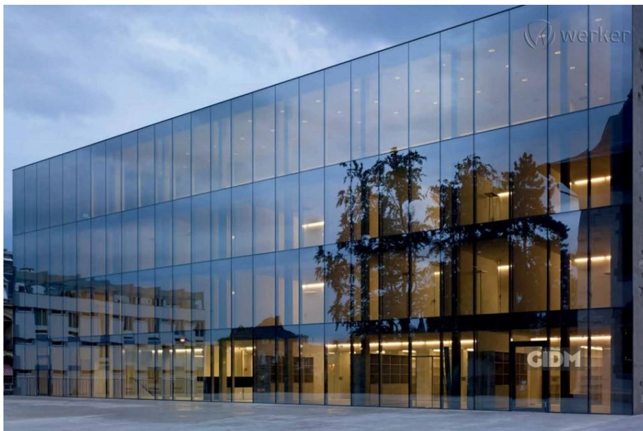
Рисунок 18 - пример структурного остекления фасадов
