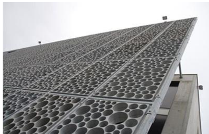
Рисунок 15 - пример СФБ на производственном корпусе в Cormondrèche
