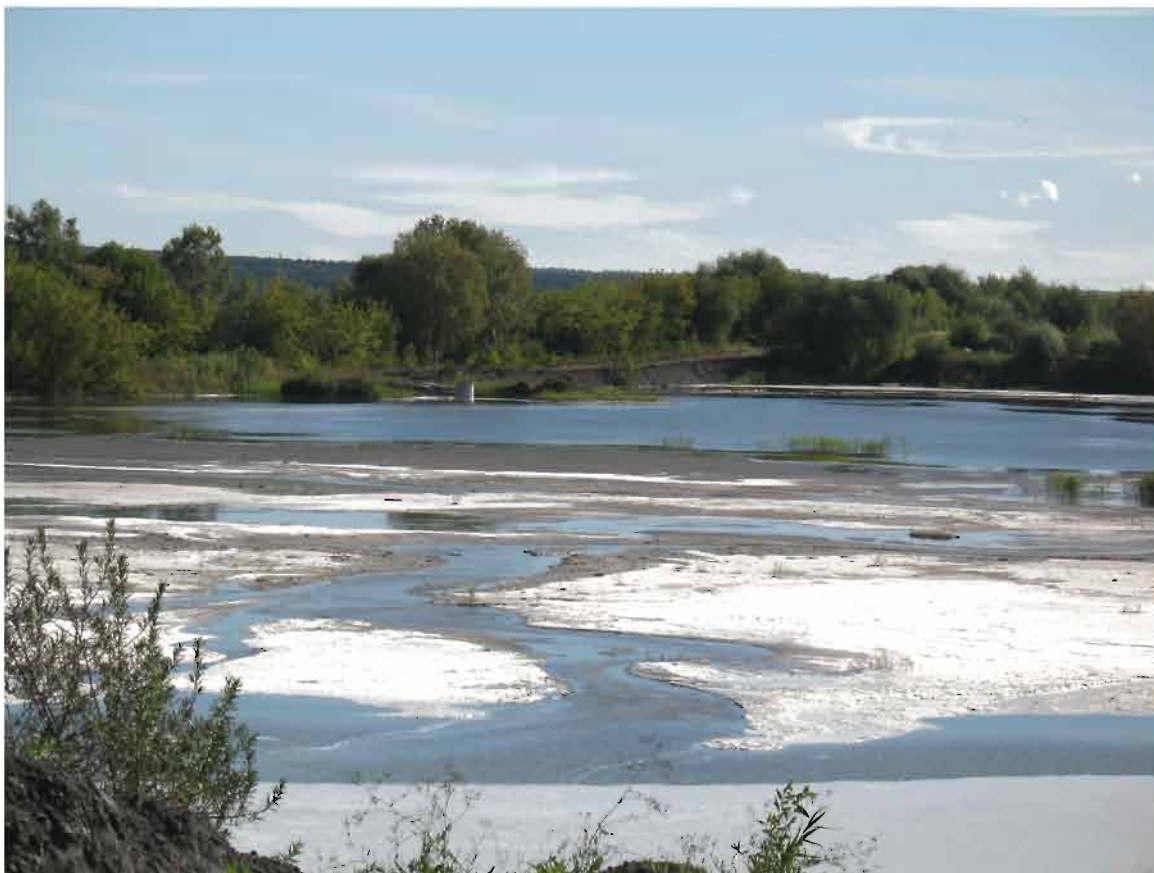
Рисунок 6- Каширская ГРЭС. Золошлакоотвал. Секция №3
