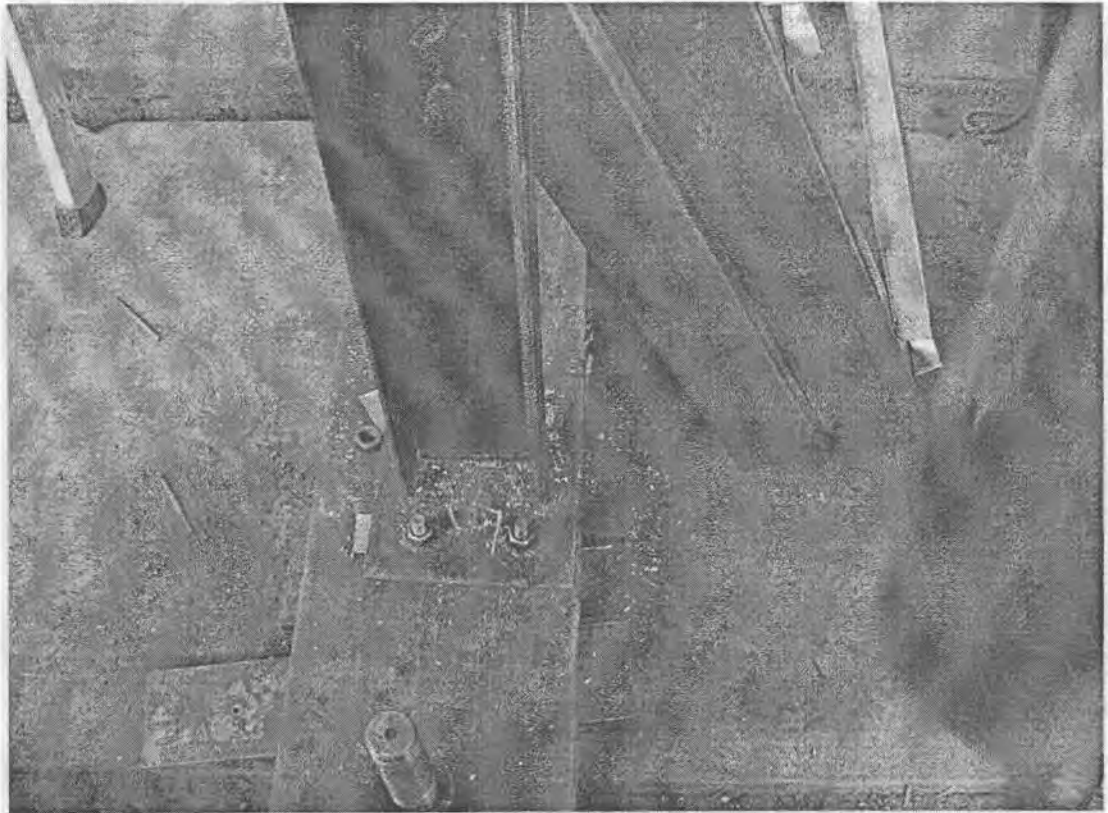
Рисунок 18. Опорный узел стойки
