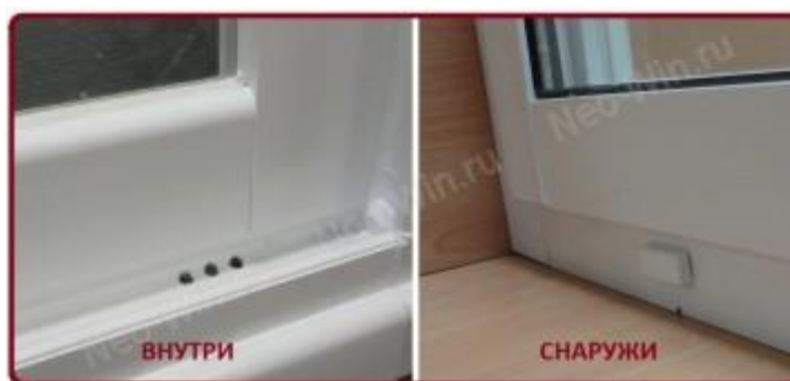
Рисунок 8 – Дренажное отверстие
