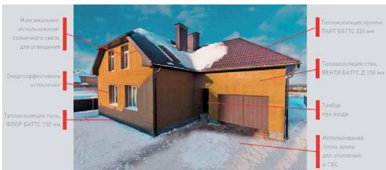
Рисунок 1.9 - Схема энергоэффективных технологий, использованных при строительстве дома Natural Balance
