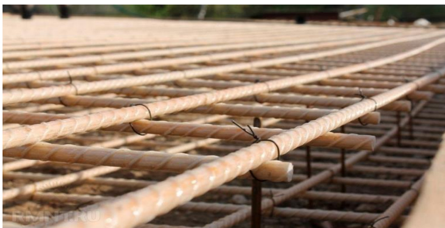
Рисунок 3.2 – Стеклопластиковая арматура в процессе строительства
