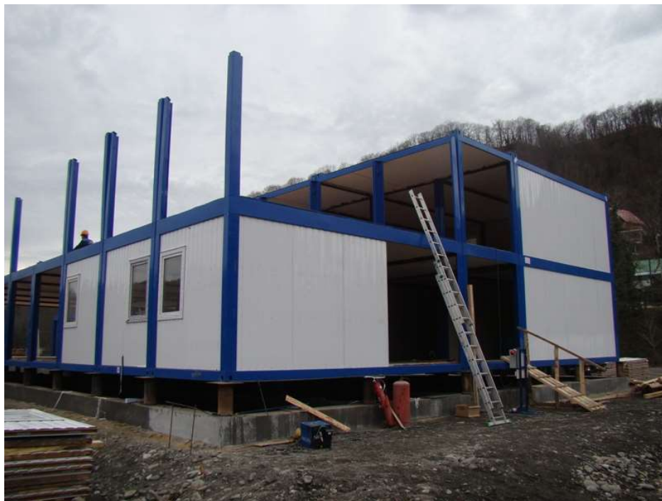
Рис.6 Временное здание сборно-разборного типа
