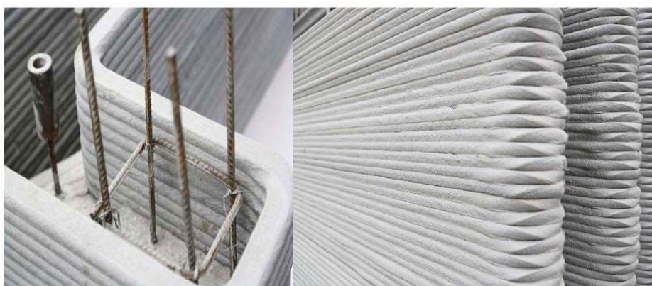
Рис.14 Технология 3D-печати компании WinSun
