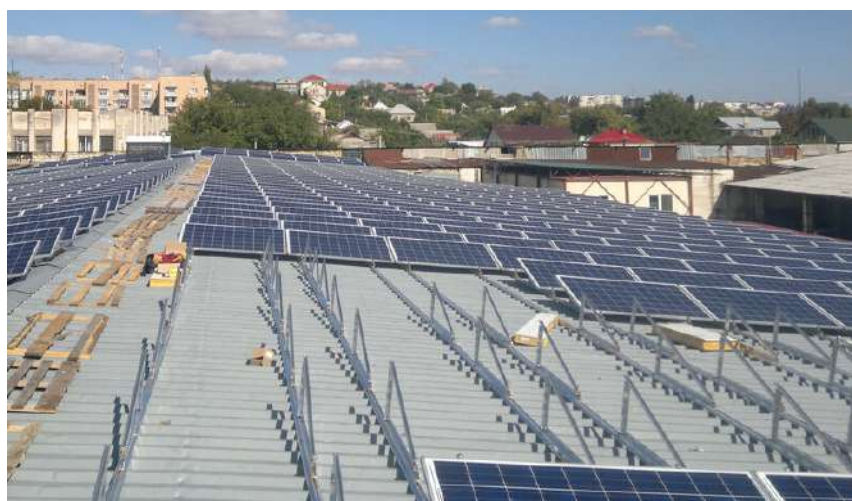
Рис. 3.31. Крепление солнечной панели на плоскую крышу
