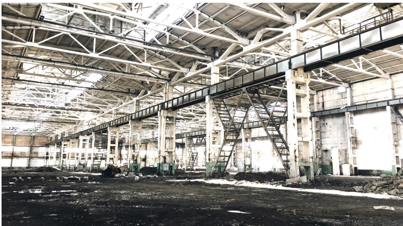
Рисунок 11 – Выполненный демонтаж строительных конструкции зданий цеха
