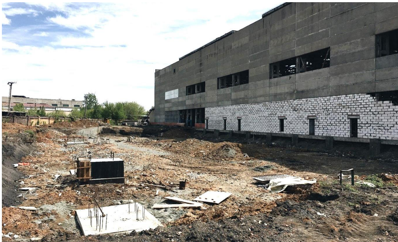
Рисунок 10 – Выполненные земляные работы по шихтовому отделению – демонтаж строительных конструкций здания цеха (по проекту демонтажа) выше отметки \pm 0.000 (100 %), представлено на рисунке 11.
