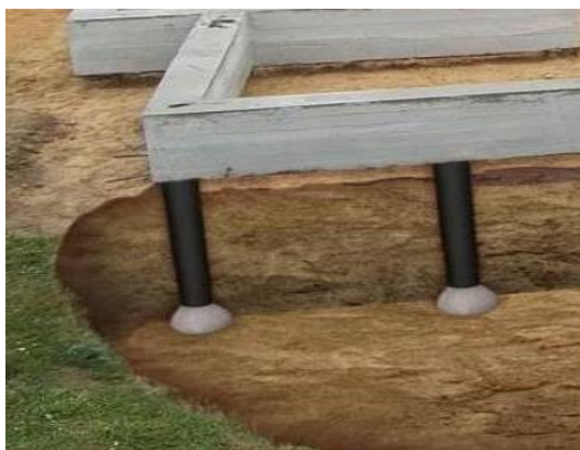
Рисунок 6– Свайный фундамент
