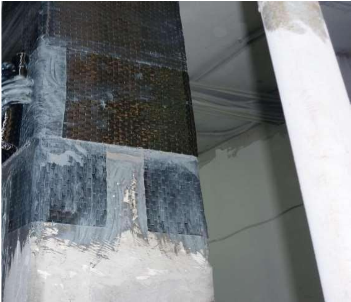
Рис.8.16.Усилие колонны
