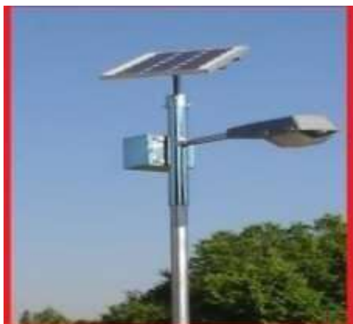
Рис.7.7.Освещение с помощью солнечных батарей
