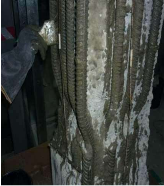
Рис.8.14.АНТИКОРРОЗИЙНОЕ ПОКРЫТИЕ АРМАТУРЫ
