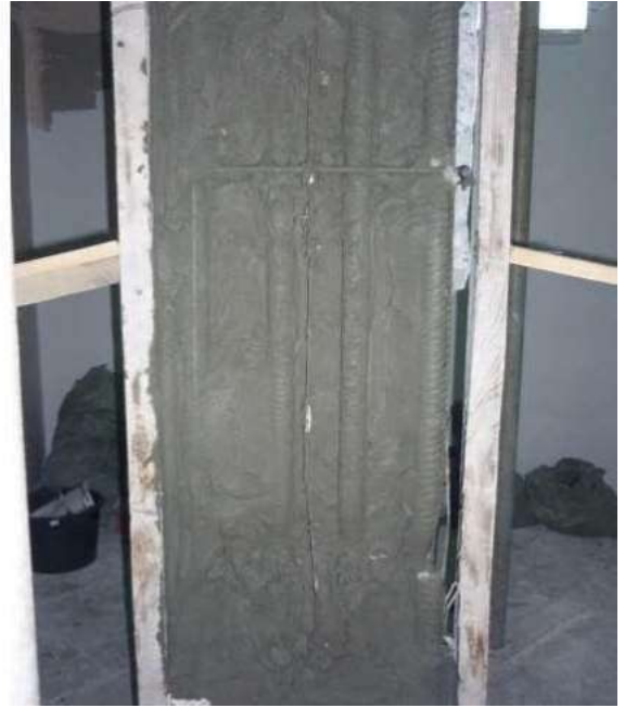
Рис.8.14.АНТИКОРРОЗИЙНОЕ ПОКРЫТИЕ АРМАТУРЫ
