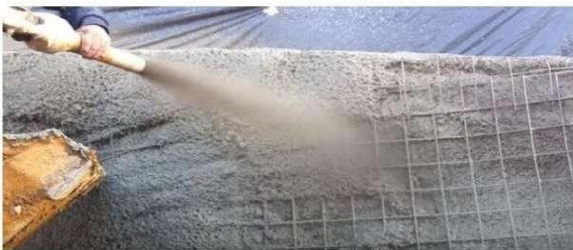
Рис.8.11. укреплениа с помощью бетона
