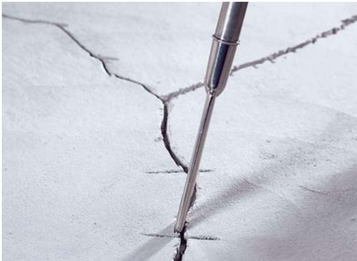
Рис.5.4. Отслеживание появления трещин с помощью техника видеокамеры.
