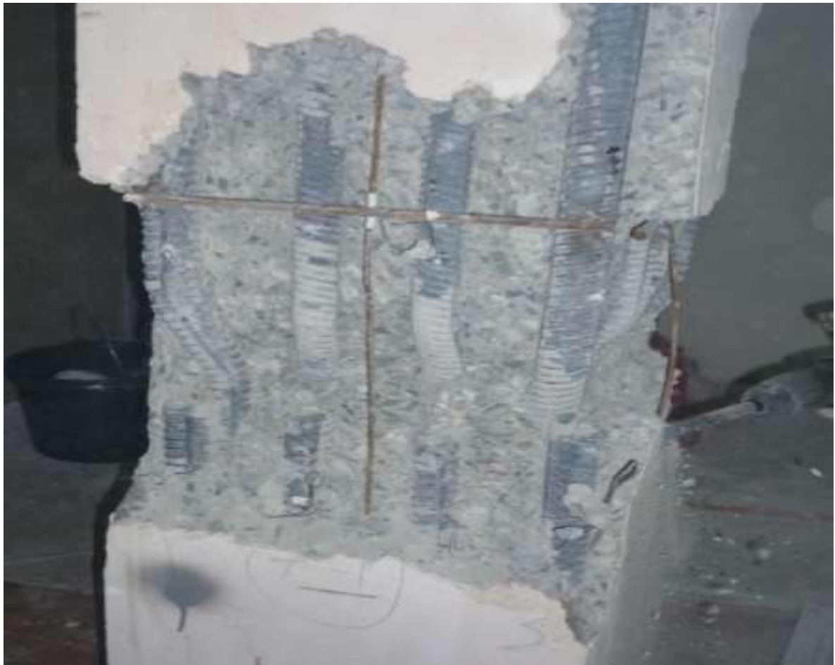
Рис.8.12 Колонна до ремонта
