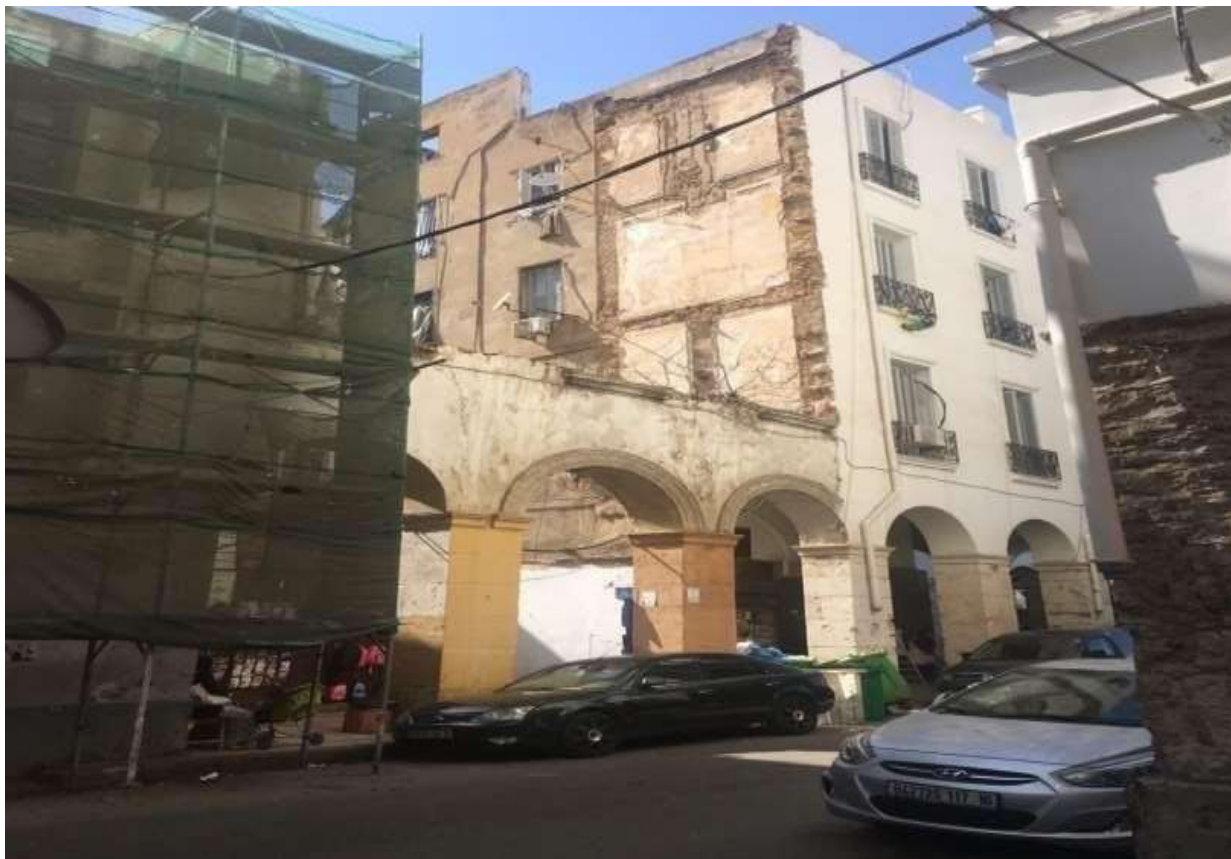
Рис.4.2. внешний фасад старого дома в городе Касба
