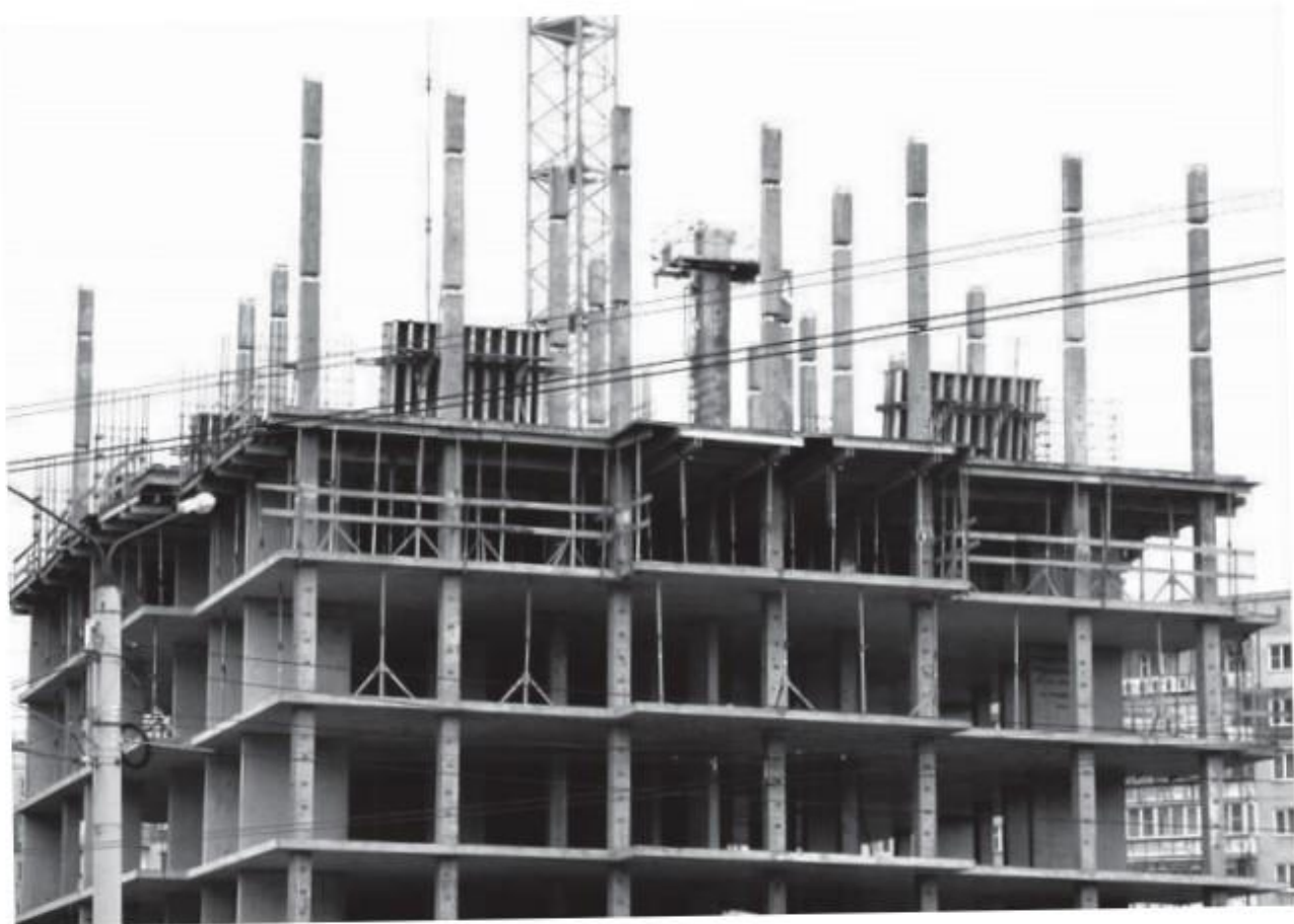
Рисунок 1.5 Безбалочные монолитные перекрытия по сборным колоннам
