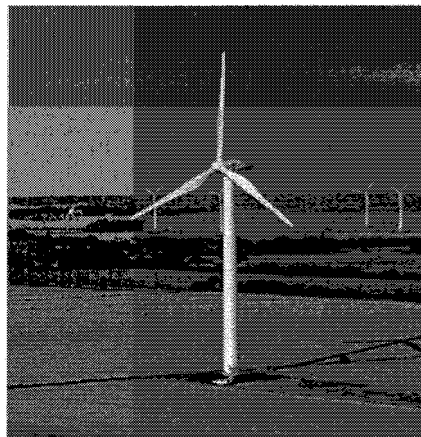
Рис. 1. ВЭУ с горизонтальной осью вращения
