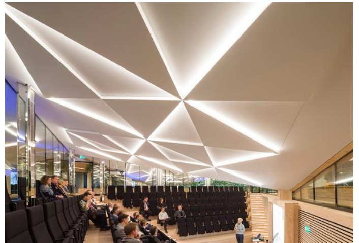
Рисунок 4.1.11-12. Модульные подвесные потолки с подсветкой.
